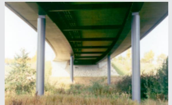
**Brückenuntersicht mit Stützen-Federlamelle**
